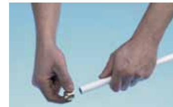
Нанизывание пресс-штулки на трубу
