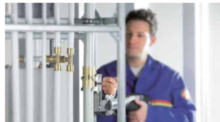
Использование электро-прессового инструмента с насадкой TECE
